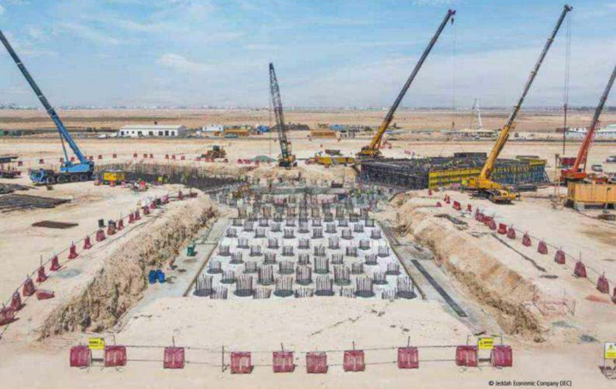
Das auf einer Pfahlkonstruktion basierende Fundament des Jeddah Tower in Saudi-Arabien. The Jeddah Tower in Saudi Arabia: It's foundations are based on a pile design.
