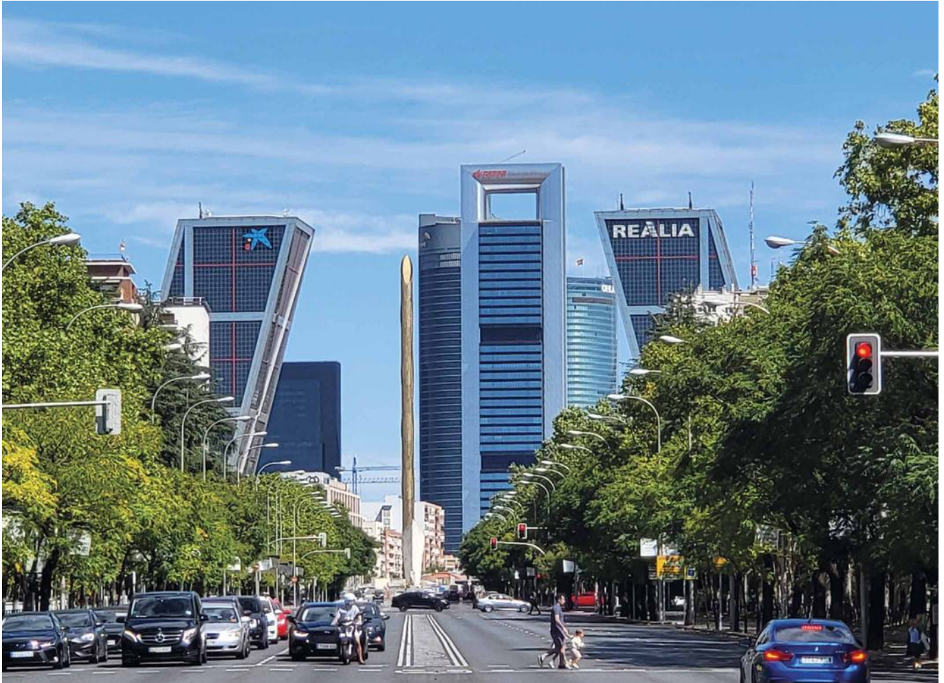
Die Stadt ist Standort zahlreicher multinationaler Firmensitze und unternehmensbezogener Veranstaltungen (hier im Bild: Paseo de la Castellana, Stadtteil Chamartín). The city is home to a multitude of multinational company headquarters and events related to the business world (pictured here: Paseo de la Castellana, Chamartín district).
